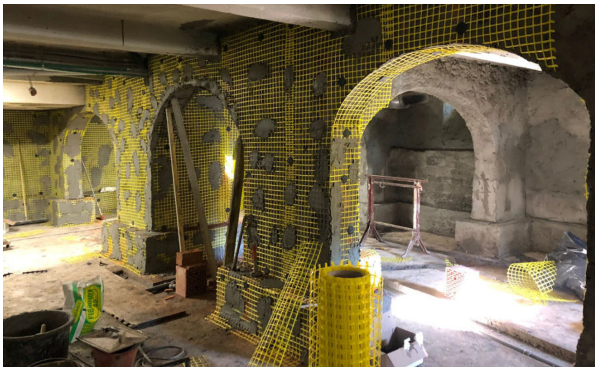
Illustration der Anwendung des SEALBAND-Gewebes in Kombination mit der Dichtschlämme CERMIPROOF SEAL G
