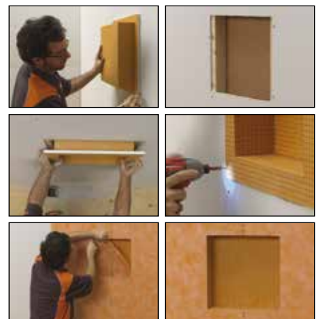
Einbau in Gipskarton
