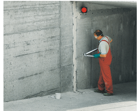
Rissverpressung mit PCI Apogel.
